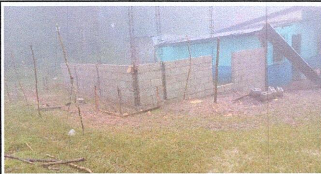
Foto 3: LELVANTADO DE PARED DE COCINA
